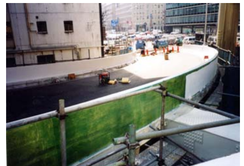
AK-90 を壁高欄曲線部に使用
