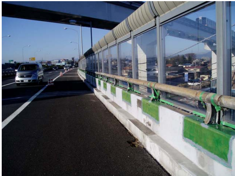
AK-40/40 を壁高欄の前面と上面に使用
