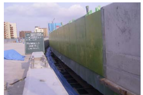
AK-20/20 を壁高欄曲線部に使用
